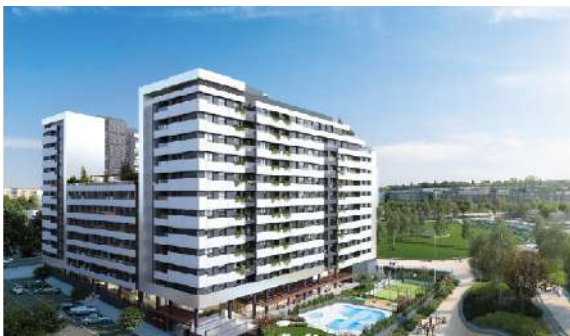
RIVER PARK I y II 383 viviendas en altura Rent Madrid Río, Madrid
