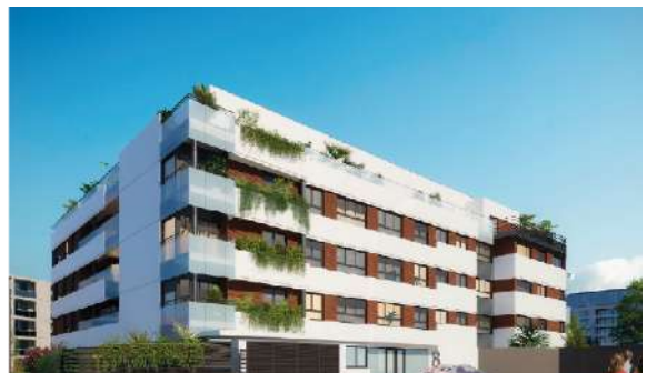
POZUELO RESIDENCES 46 viviendas en altura Pozuelo de Alarcón, Madrid
